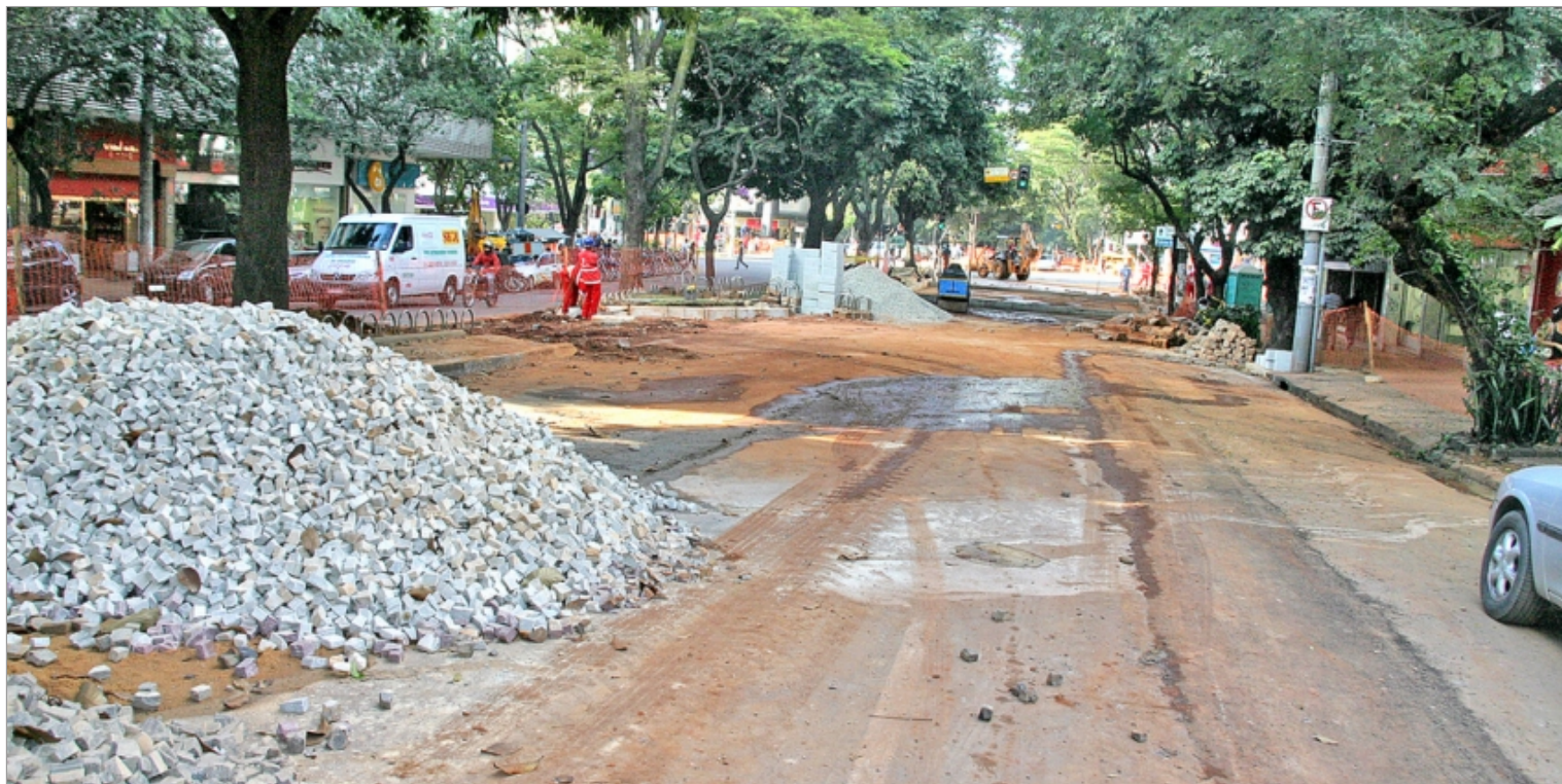
obras em rua de BH
